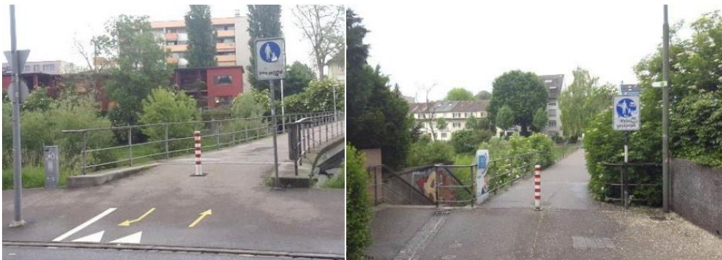
Birssteg, Seite Basel-Stadt (links), Birssteg, Seite Birsfelden (rechts), Bilder aus (Bau- und Verkehrsdepartement des Kantons Basel-Stadt)
